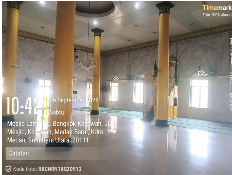
Gambar 1. Empat tiang penyanggah Masjid Lama Gang Bengkok
